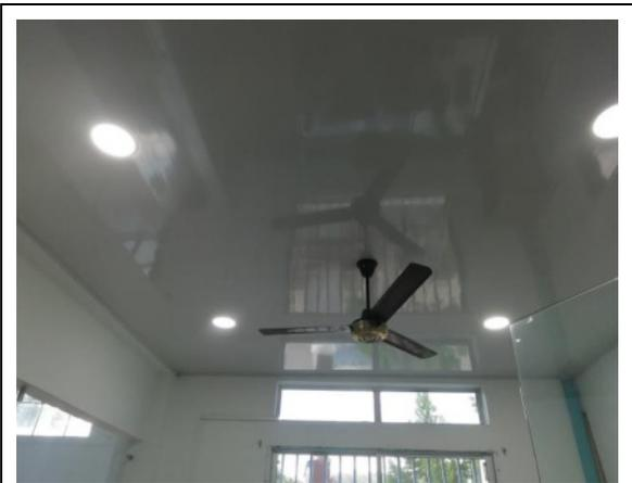
Cielo raso en PVC, incluye perfilaría, ventilador de techo KDK y bala tipo LED
