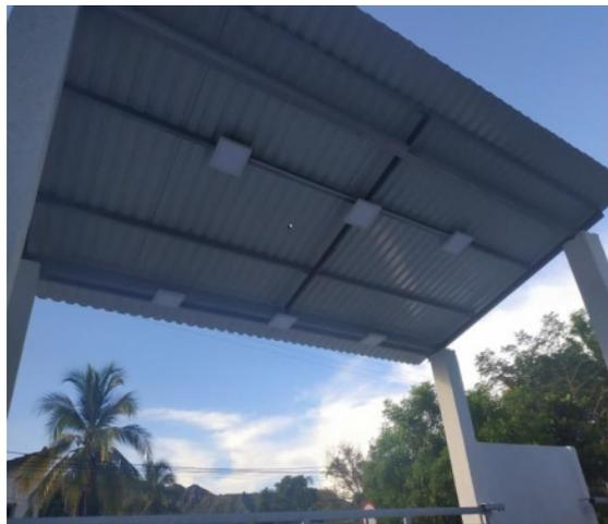
Teja cubierta arquitectónica, estructura metálica en perfil incluye correas y templetes
